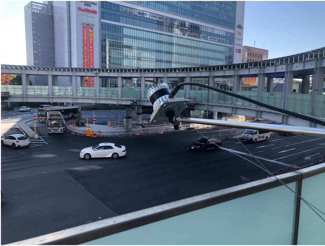
設置した3D-LiDAR
